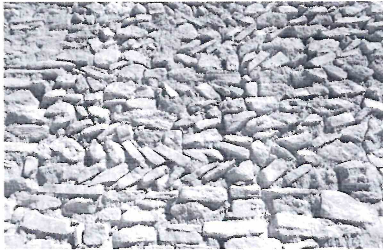
الصورة رقم 07: تبين تقنية البناء بقصر عين ماضي بالاغواط
