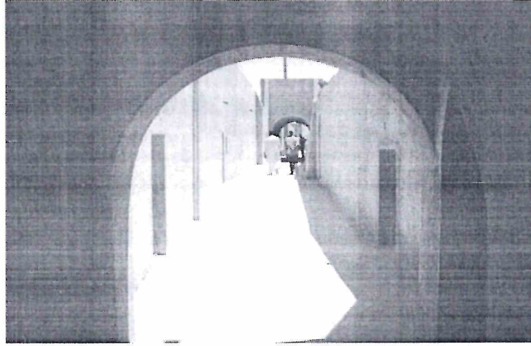
الصورة رقم 05: تبين احد الممرات قصر تمرنة سيدي عمران عمل الباحث
